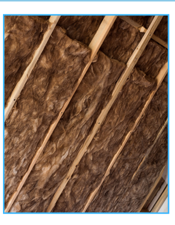
Realizzazione di un isolamento termico dei tetti;
